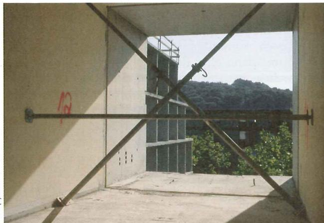
*Setzkasten: Bis zur Montage der neuen Holzfassade wurde das Betongerippe durch Baustützen ausgesteift*
