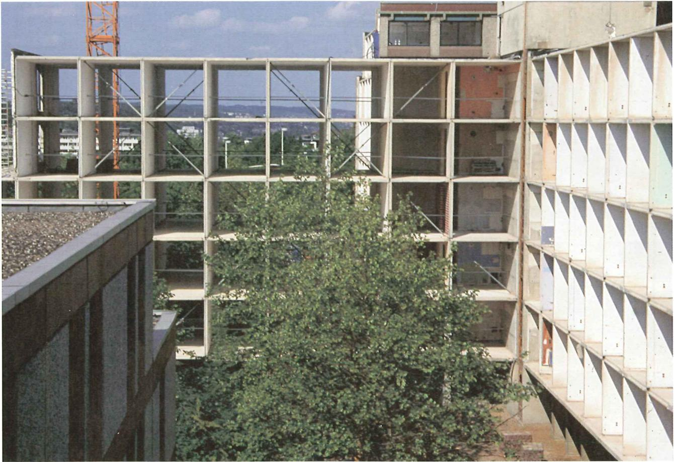
„ist sehr passiv.“ Diese Passivität führte in Kombination mit der hochwärmegeämmten, dichten Fassade in einigen Appartements zu Schimmelbildung. Daher sollte im zweiten Bauabschnitt (2002-2003) unbedingt eine Lüftungsanlage installiert werden, um Luftaustausch und Raumhygiene vom Studentenverhalten unabhängig zu machen. Daraufhin entschied sich der Bauherr auf anraten der Architekten konsequenterweise, den zweiten Wohnheimblock gleich zum Passivhaus umzubauen.
