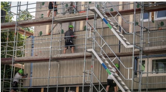
Abb. 9: Unterkonstruktion aus Konstruktionsvollholz (KVVH)
