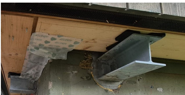
Abb. 6: Eingebundene Stahlträger (HEA)
