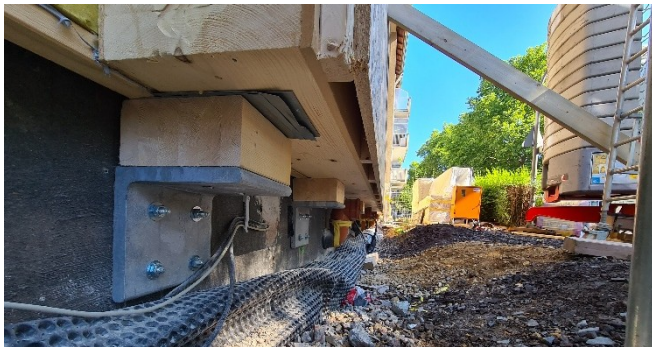
Abb. 3: Stahlwinkel mit Sockelbereich mit Auflagerung oben
