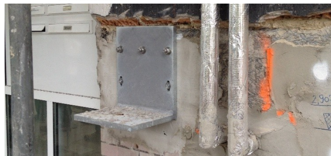
Abb. 5: Stahlwinkel im Sockelbereich mit Auflagerung unten
