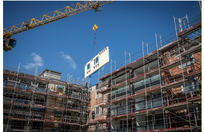
Abb. 11: Montage einer seriellen Sanierung
