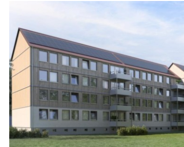
Gebäude saniert – Südseite
