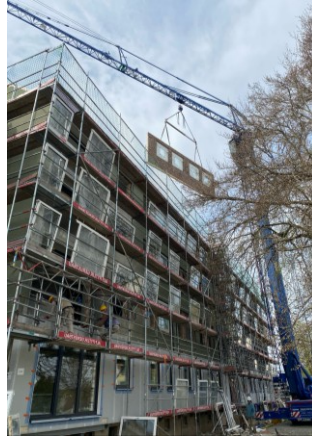
Einbau der vorgefertigten Holzrahmenbauwände
