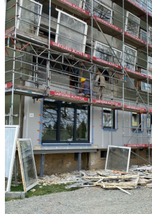
Ausbau der alten Fenster
