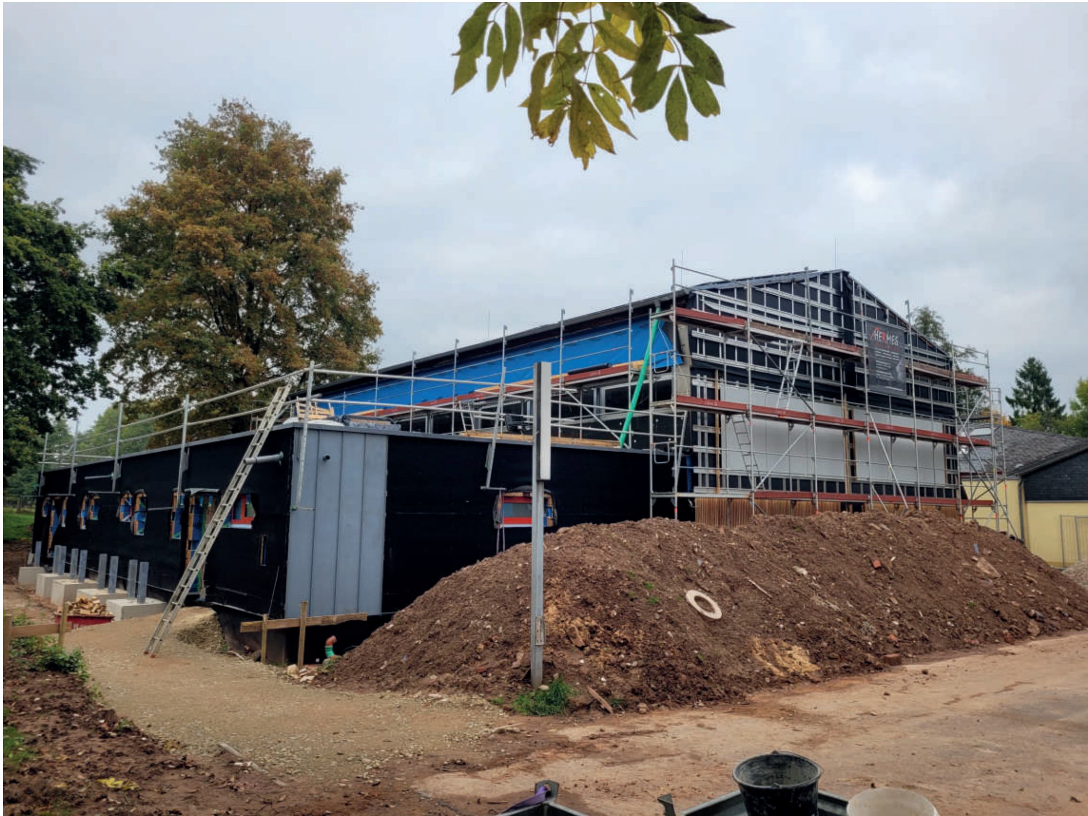
Gereinigte Zinkstehfalzdeckung auf wiedereingebaute Konstruktionshölzer des abgebauten Pultdaches
