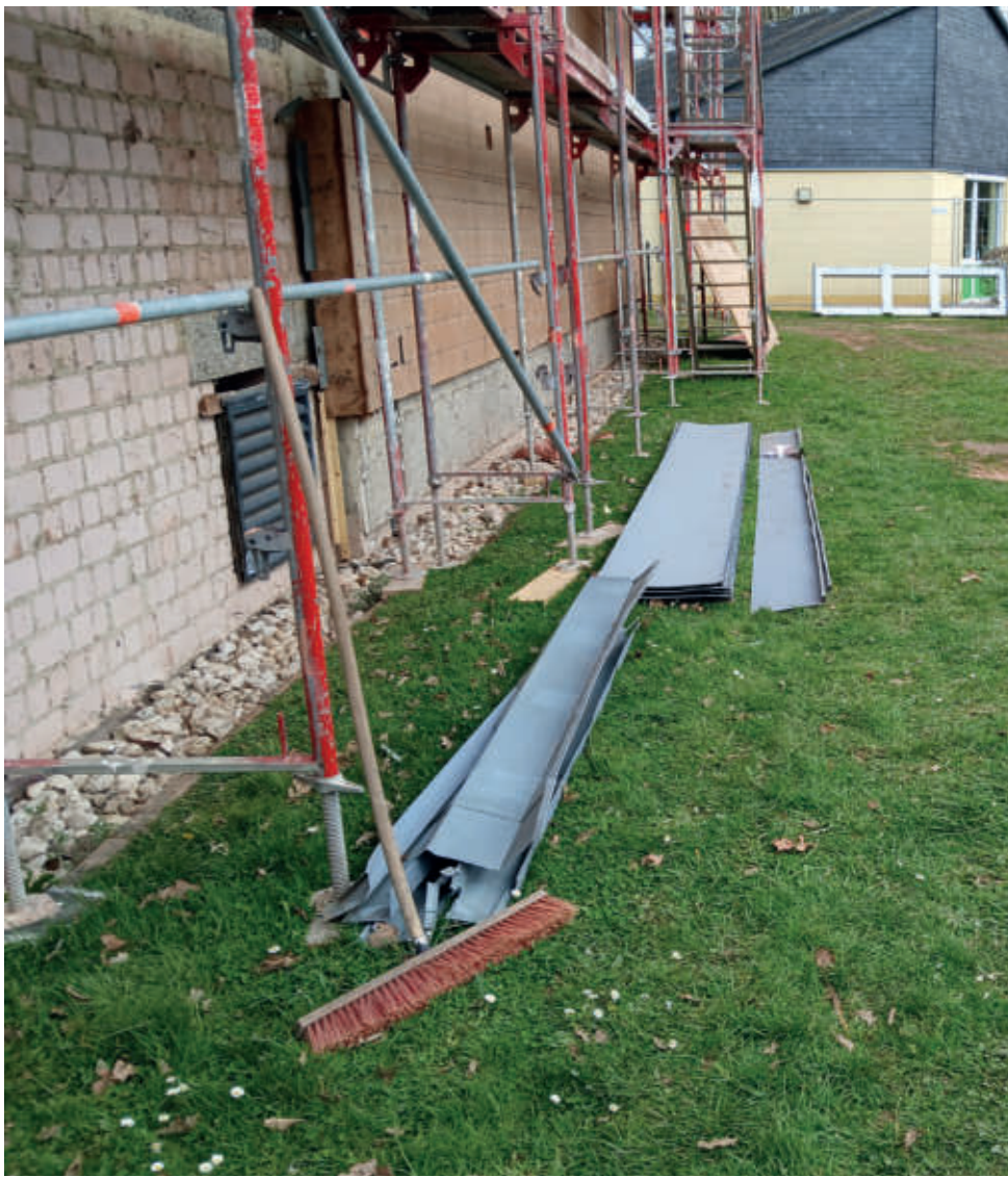
Ausgebaute Zinkstehfalzdeckung
