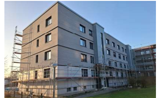
Foto: dena / Rheinwohnungsbau
