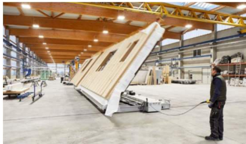
Quelle: Opitz Holzbau
