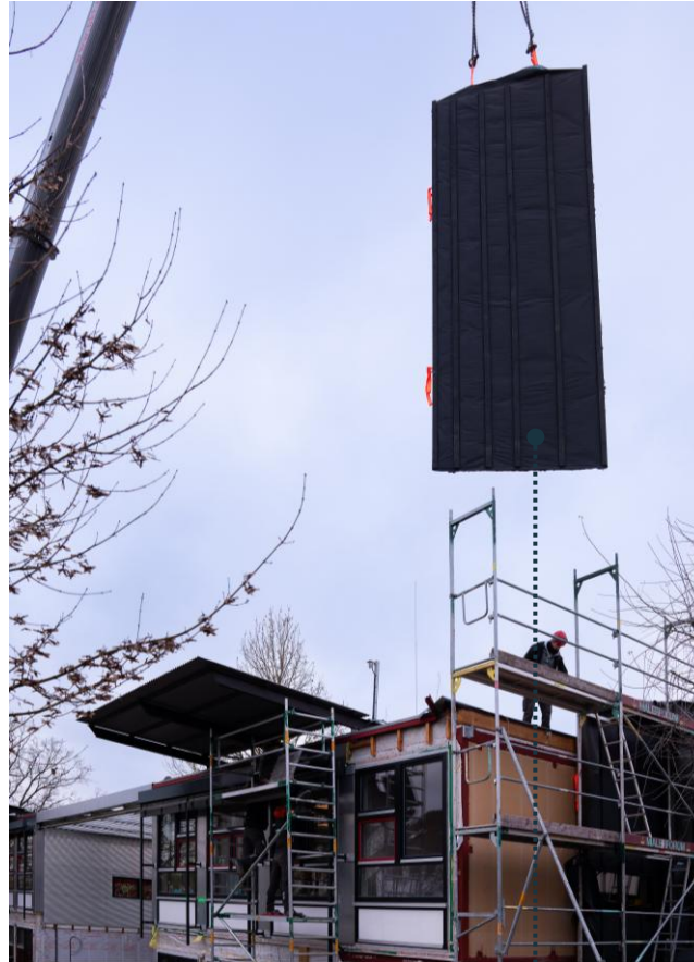
Montage von 65 Holz-Rahmen-Module = 820 m 2 Fassadenfläche
