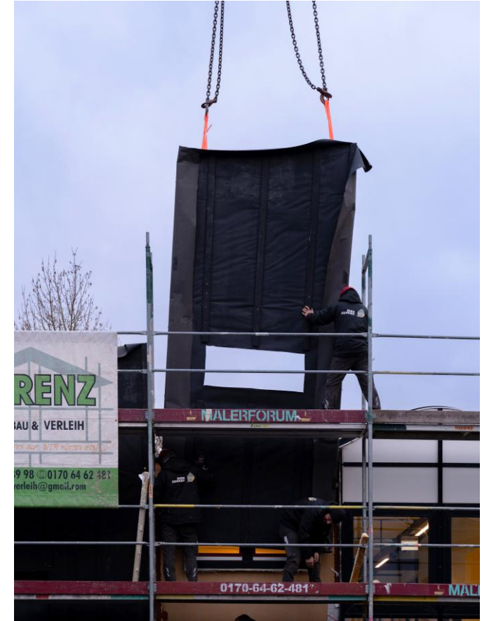
Montage von 65 Holz-Rahmen-Module = 820 m 2 Fassadenfläche
