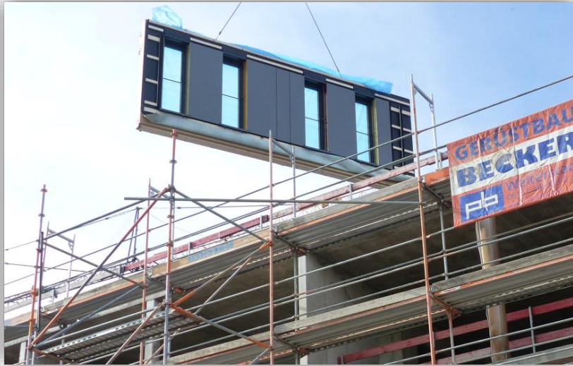
EnerPHit Sanierung Stadtteilschule Arheilgen © PHI
