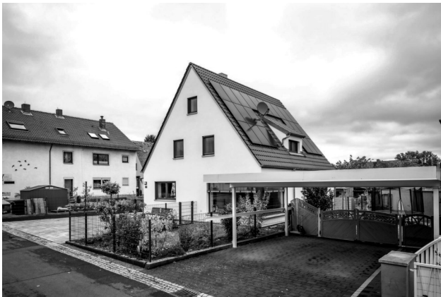
Bild 6: Die PV-Anlage auf dem Dach sorgt als Stromquelle (Foto: dena/Claudius Pflug)
