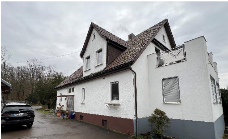
Bildquelle: Holzbau Göser
