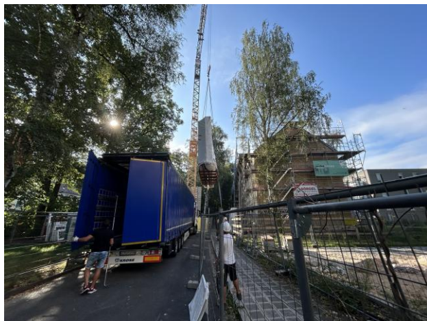
Anlieferung der Fassade
