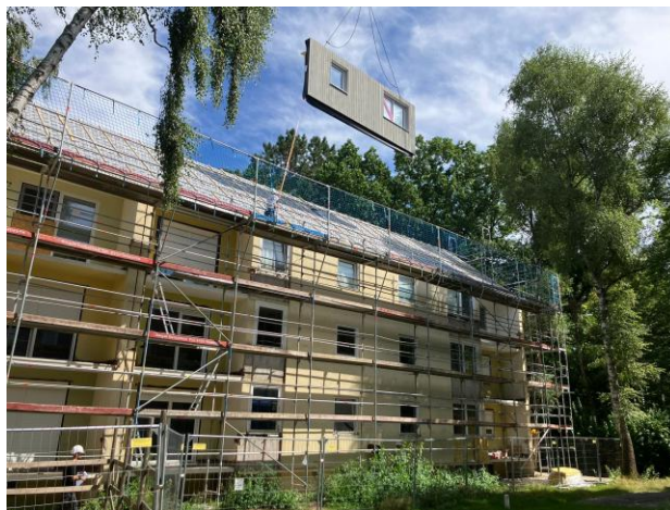
Fassadenelement wird eingehoben
