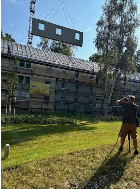
Fassade wird platziert
