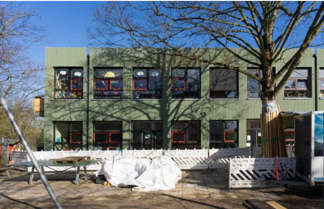
Bauphase 1: Fassade Jahreswechsel 2024/25
