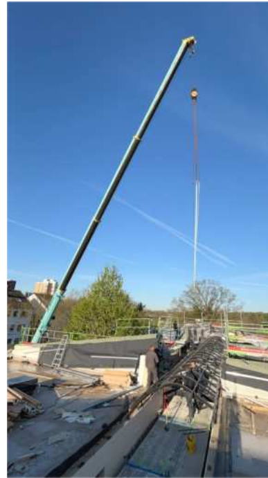
Bauphase 2: Dachstuhl Osterferien 2025
