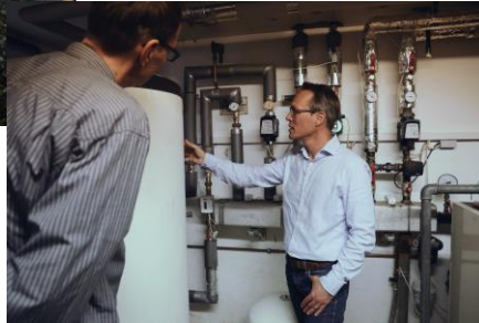
Fernüberwachung von Heizungsanlagen
