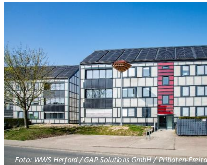
Foto: WWS Herford / GAP Solutions GmbH / Pribaten-Freitag
