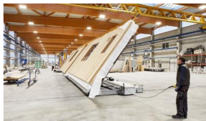
Quelle: Opitz Holzbau
