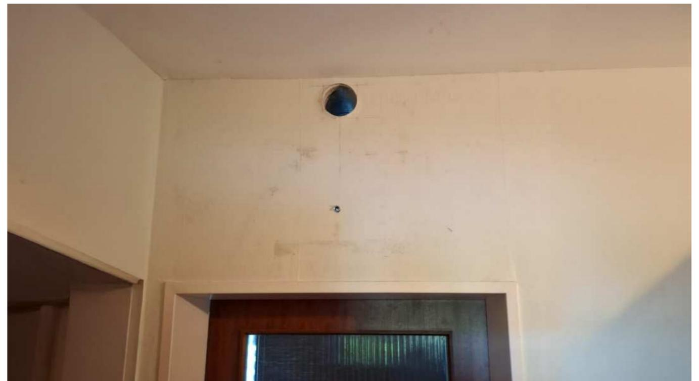
Kernbohrung mit Schutz vor Putzschäden
