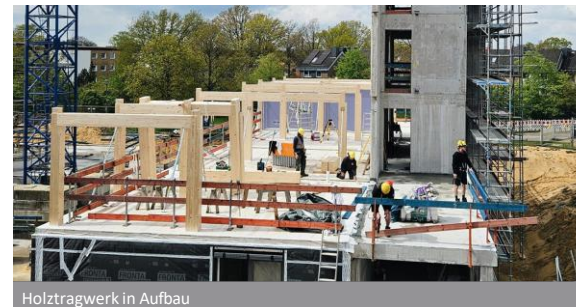
Holztragwerk in Aufbau
