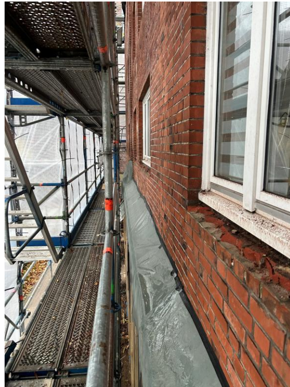
Fehlende Referenzkanten nach Abbruch der vorstehenden Sohlbank
