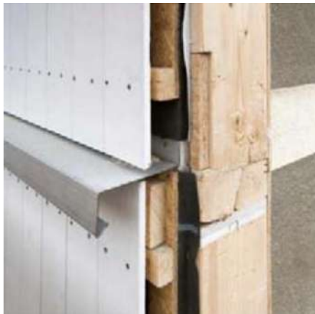
Montage an Richtbalken
