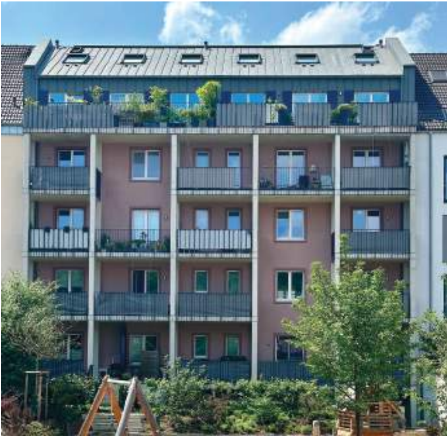
Vorgebirgsstraße, Wohnungsbau (Umbau, Sanierung, Erweiterung)
