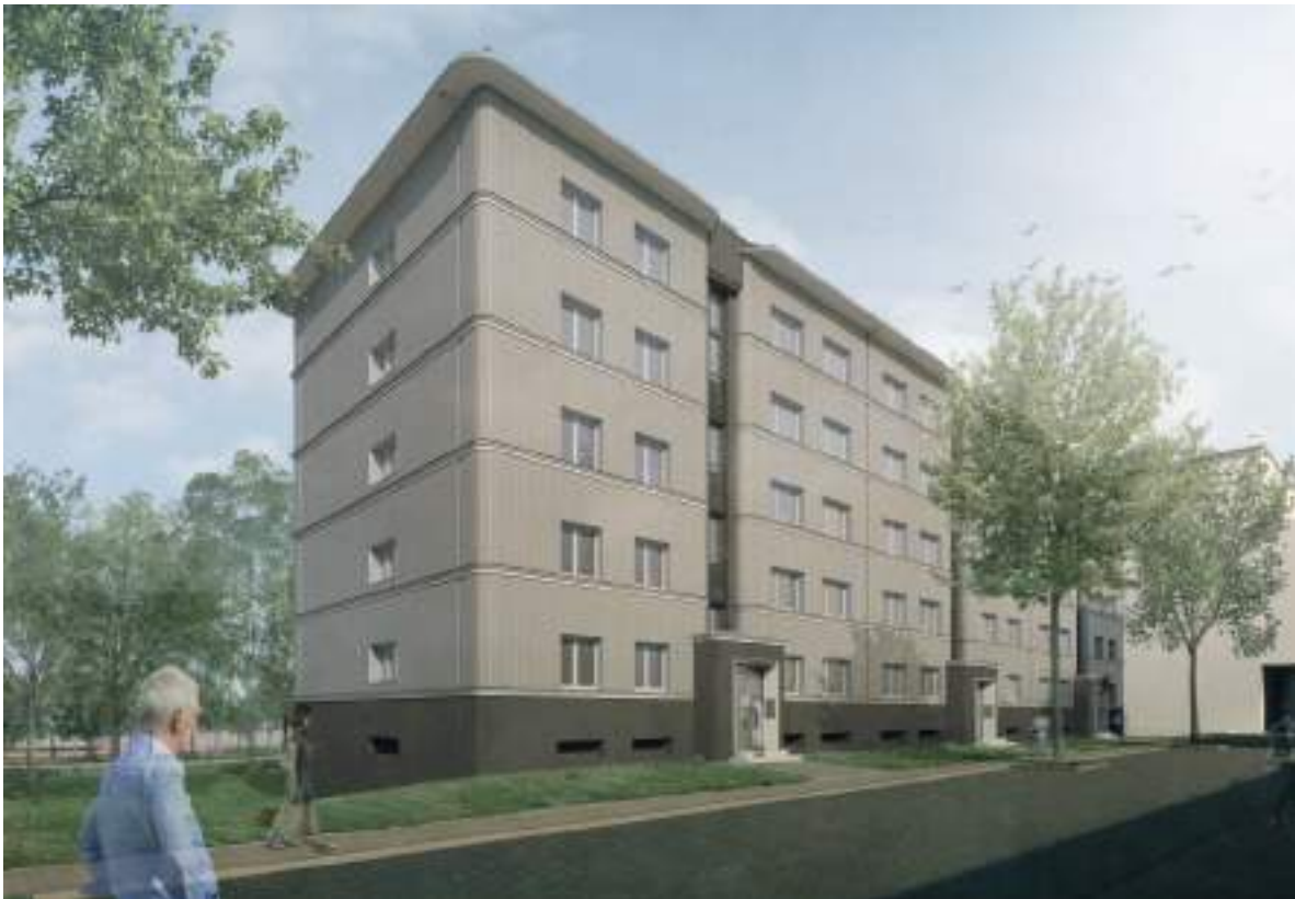
Serielle Sanierung Köln Zollstock, Wohnungsbau (Sanierung)
