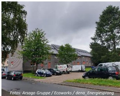
Fotos: Arsago Gruppe / Ecoworks / dena_Energiesprung
