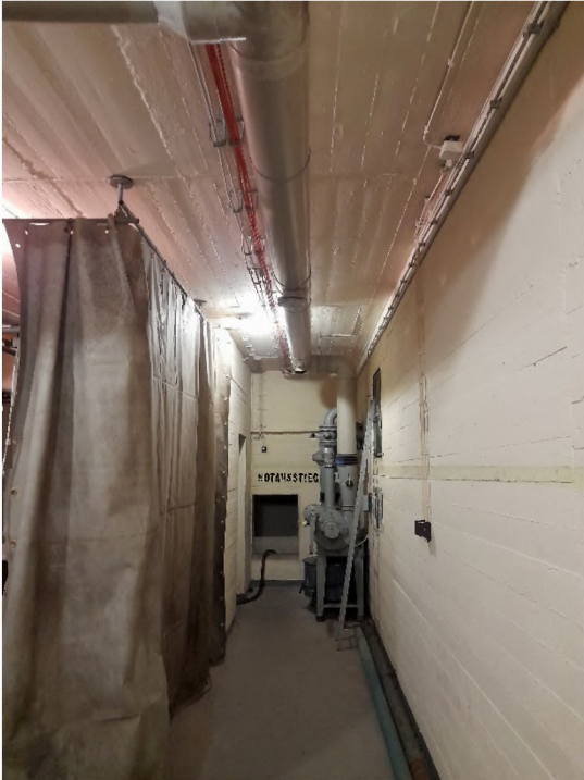
Abbildung 8: Aufnahme 1 Bunker Gebäude 05, Quelle: FRANK
