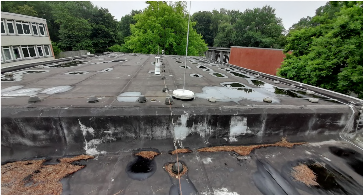
Abbildung 6: Aufnahme Dach Gebäude 05, Quelle: FRANK Ecozwei GmbH
