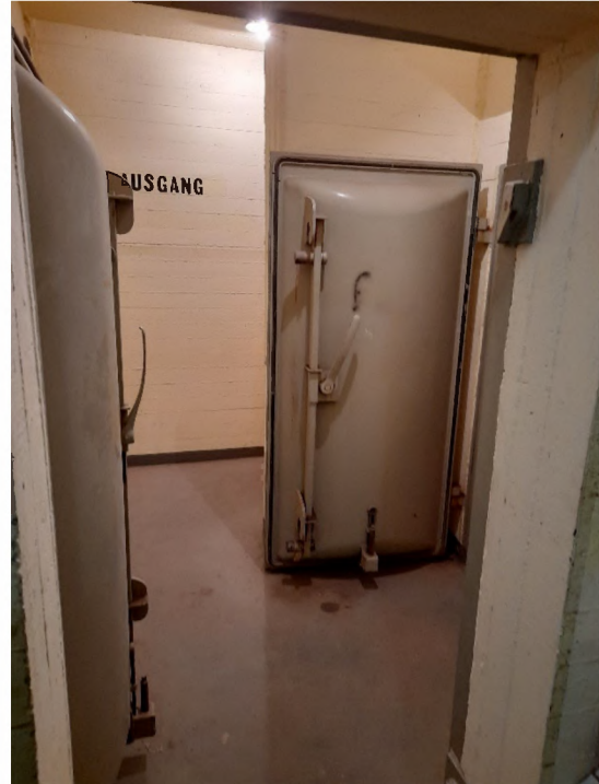
Abbildung 9: Aufnahme 2 Bunker Gebäude 05, Quelle: FRANK
