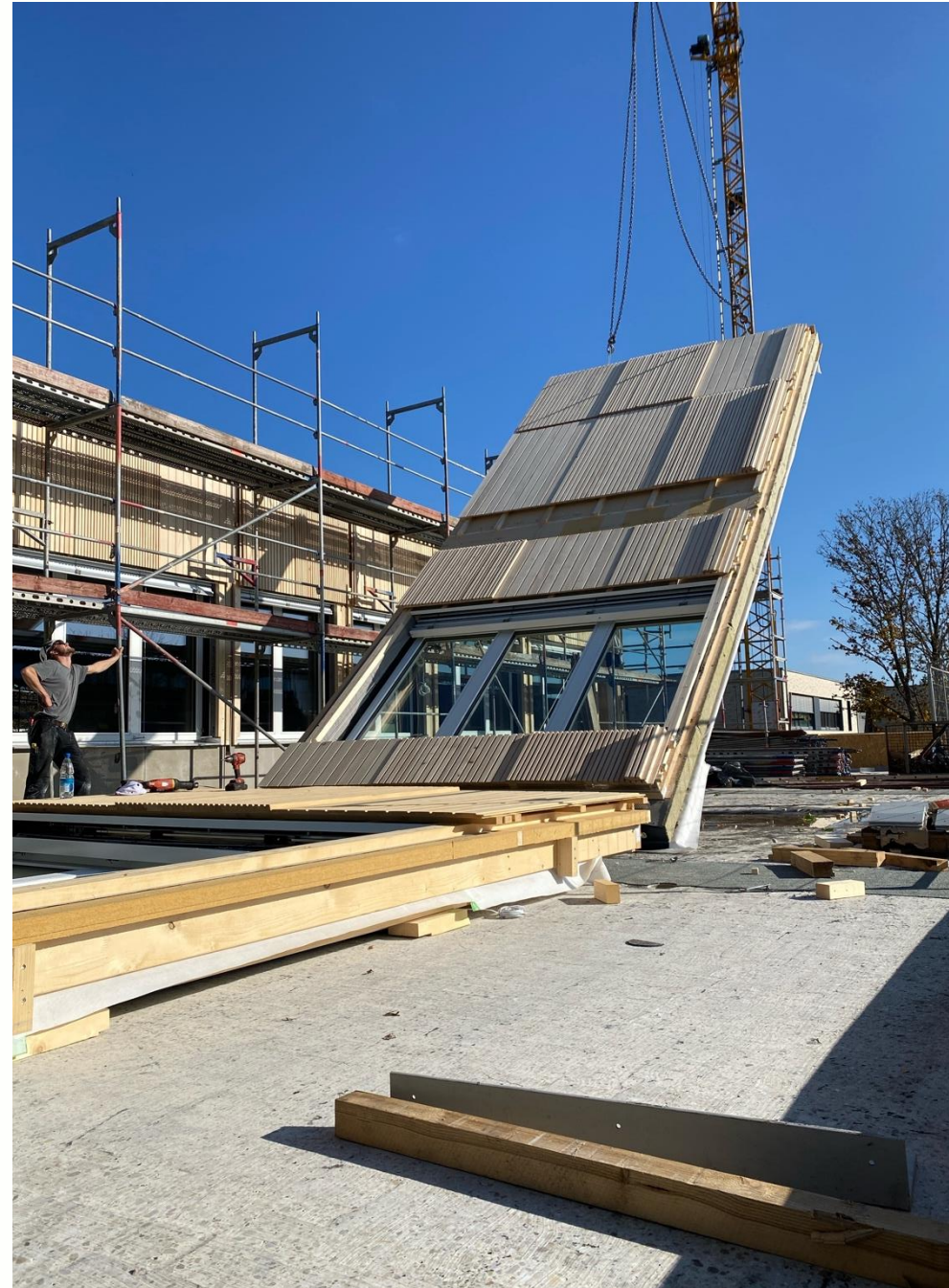
Abladen auf der Baustelle liegend, Aufrichten der Wände
