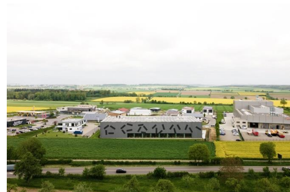
Neue Produktionshalle Gapp Holzbau Öpfingen
