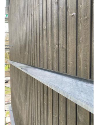
Detail Brandblech und Holzfassade
