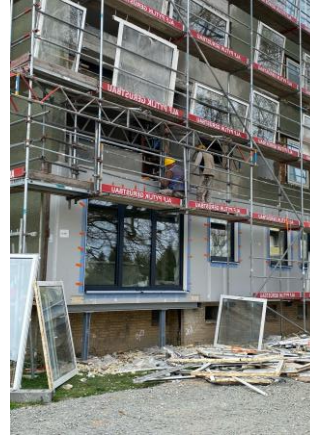
Ausbau der alten Fenster
