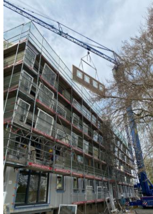
Einbau der vorgefertigten Holzrahmenbauwände
