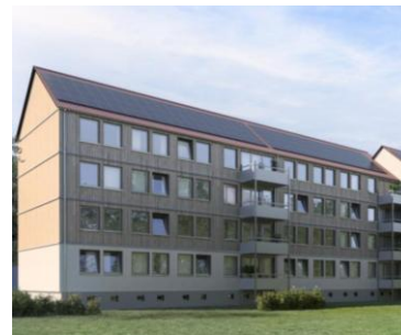
Gebäude saniert – Südseite
