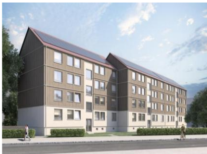
Gebäude saniert – Nordseite
