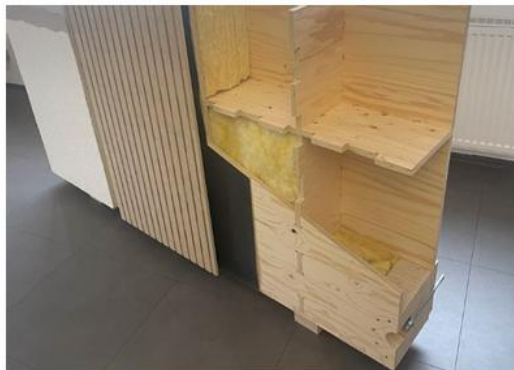
Abb.: Schichtaufbau der Future Fit Wand
