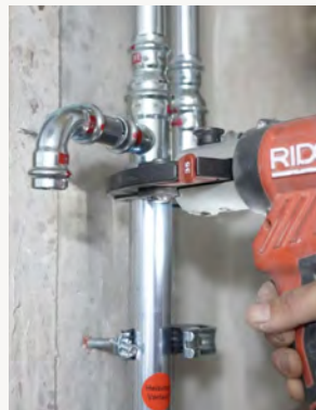
Tag 2: Installation des neuen Versorgungsstrangs
