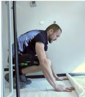
Tag 1: Schutz der Wohnung und Rückbau des Bades und der alten Strangleitungen
