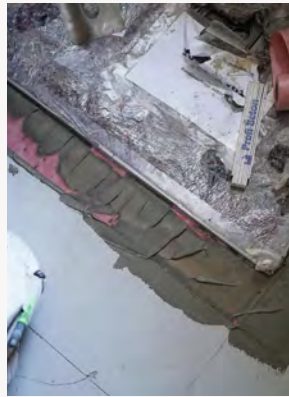
Tag 3: Montage der ebenerdigen Dusche
