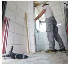
Tag 5,6 und 7: Aufbau des Blome Bades inklusive Blome Badwände, Installation der Vorwände und Verrohrung
