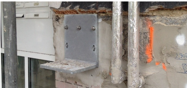
Abb. 5: Stahlwinkel im Sockelbereich mit Auflagerung unten
