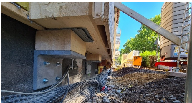
Abb. 3: Stahlwinkel mit Sockelbereich mit Auflagerung oben
