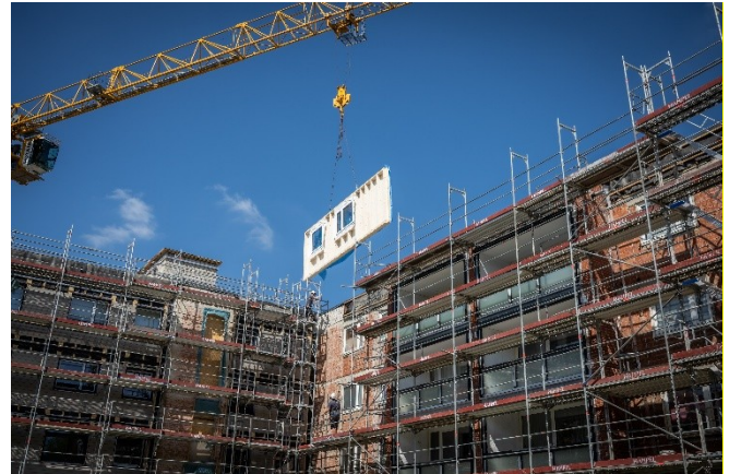
Abb. 11: Montage einer seriellen Sanierung
