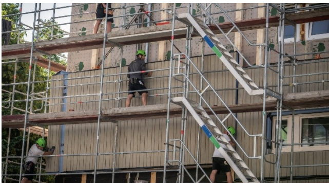
Abb. 9: Unterkonstruktion aus Konstruktionsvollholz (KVVH)
